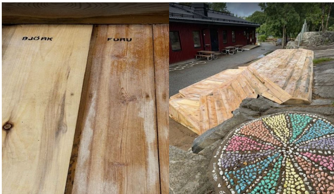
Gradäng på förskolegård byggd av återvunnet trä från Järfälla.
