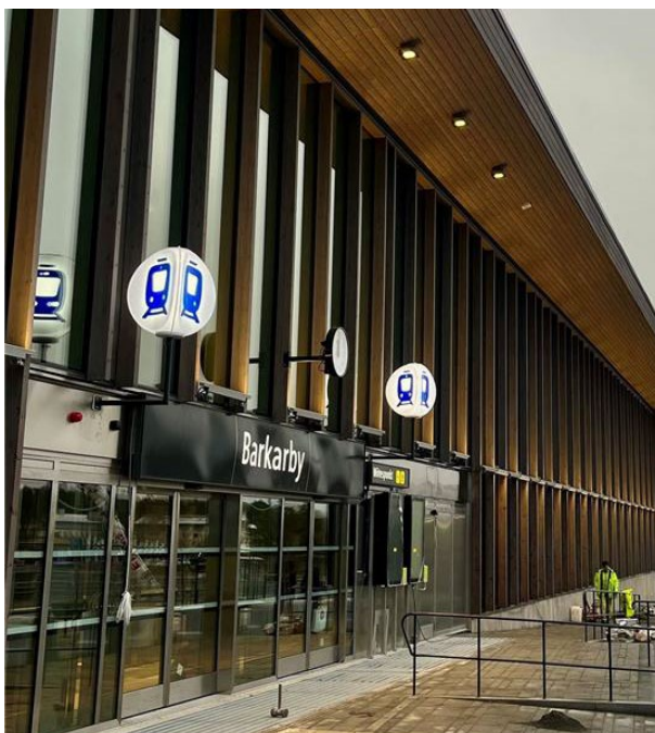
Entré till det nya stationshuset vid Veddestabron.
