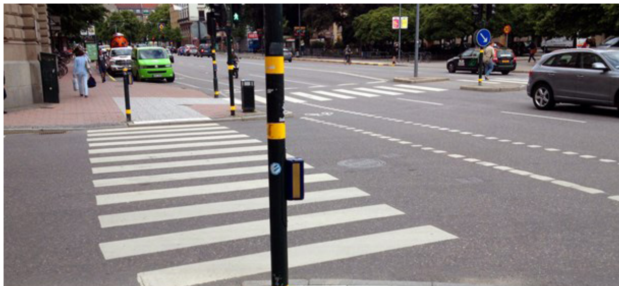
Signalreglerad korsning enligt Stockholmsmodellen med nedsänkt kantsten.
