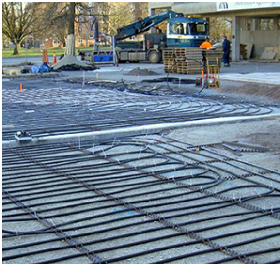
Markvärme under kommande torgyta
